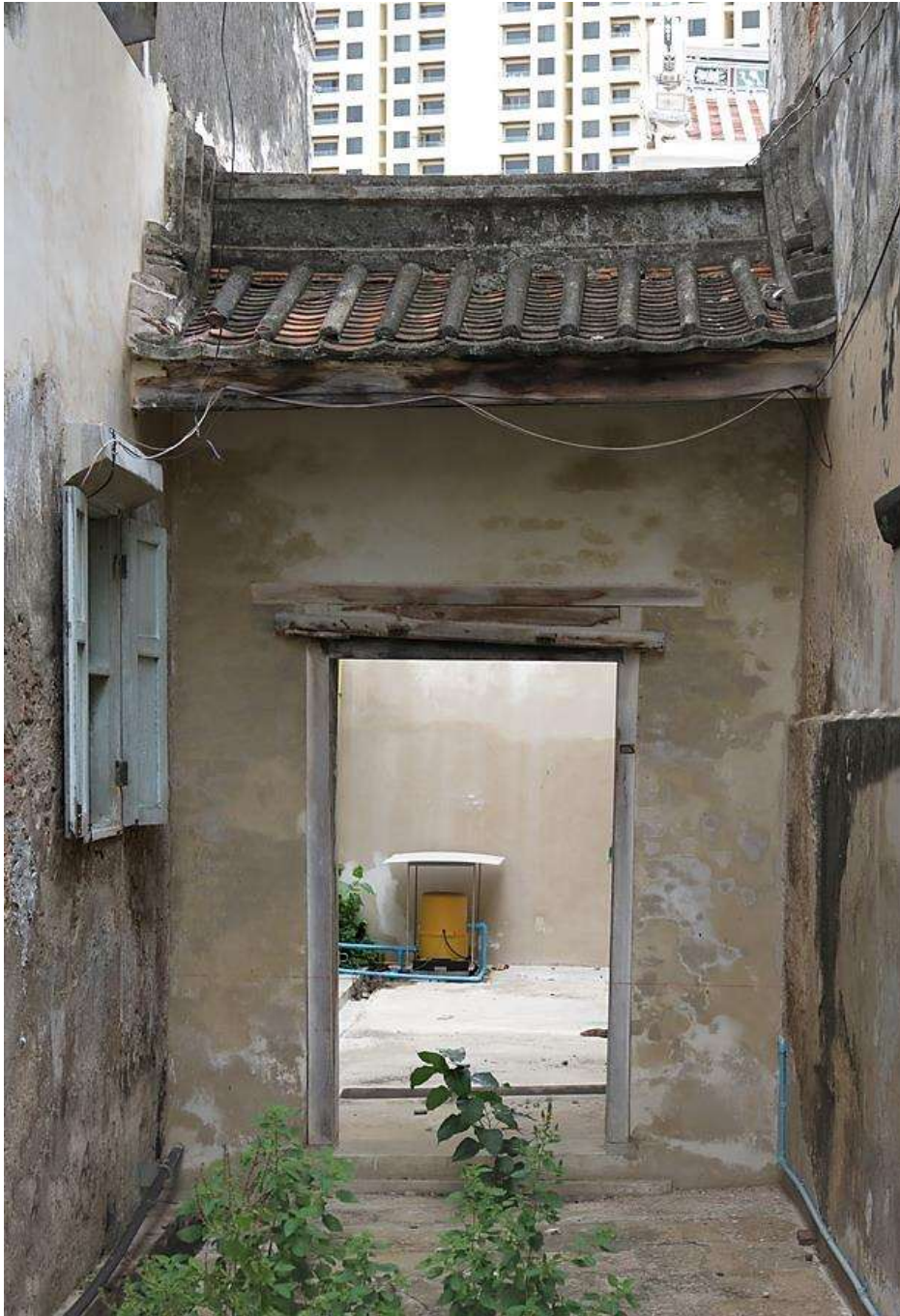
ซุ้มประตูที่เชื่อมระหว่างอาคารด้านทิศตะวันออก ยังแลเห็นหลังคามุงกระเบื้องแบบจีน ตามสภาพเดิมในปัจจุบัน (พ.ศ. ๒๕๕๘)
