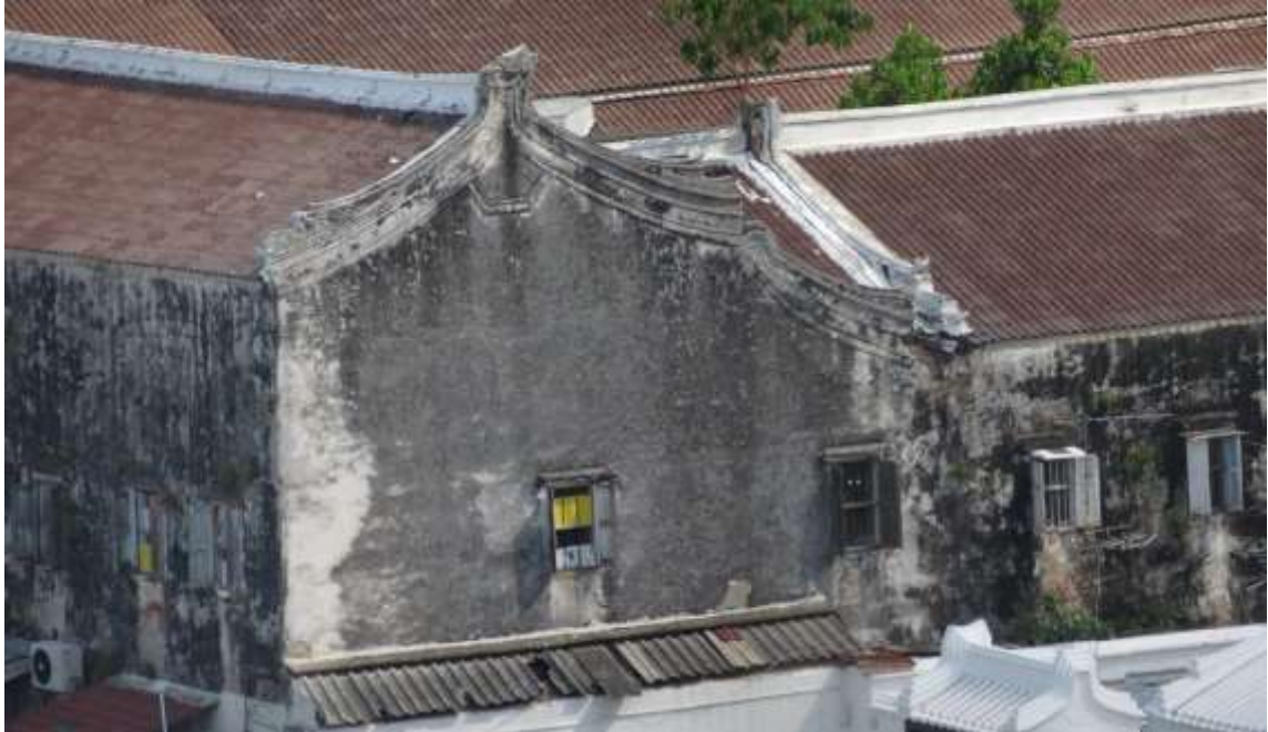
อาคารอายุจู่โล้งใช้ระบบก่อผนังขนาดใหญ่รับน้ำหนักอาคารขึ้นไปจรดถึงส่วนบนสุด
