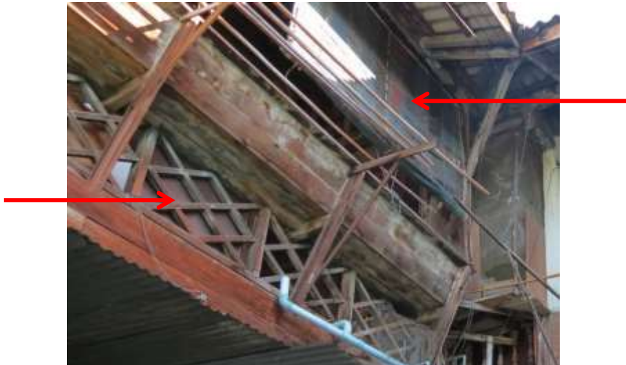
การใช้ระเบียงไม้โปร่งเป็นแนวสี่เหลี่ยมกากบาท และด้านบนเป็นมู่ลี่ ตัวอย่างอาคารฮวยจุงโล้งฝั่งทิศใต้ จากบ้านเลขที่ ๔๒๔๗ ลูกศรบนชี้ที่มู่ลี่ ลูกศรล่างชี้ที่ระเบียงไม้สี่เหลี่ยมกากบาท
