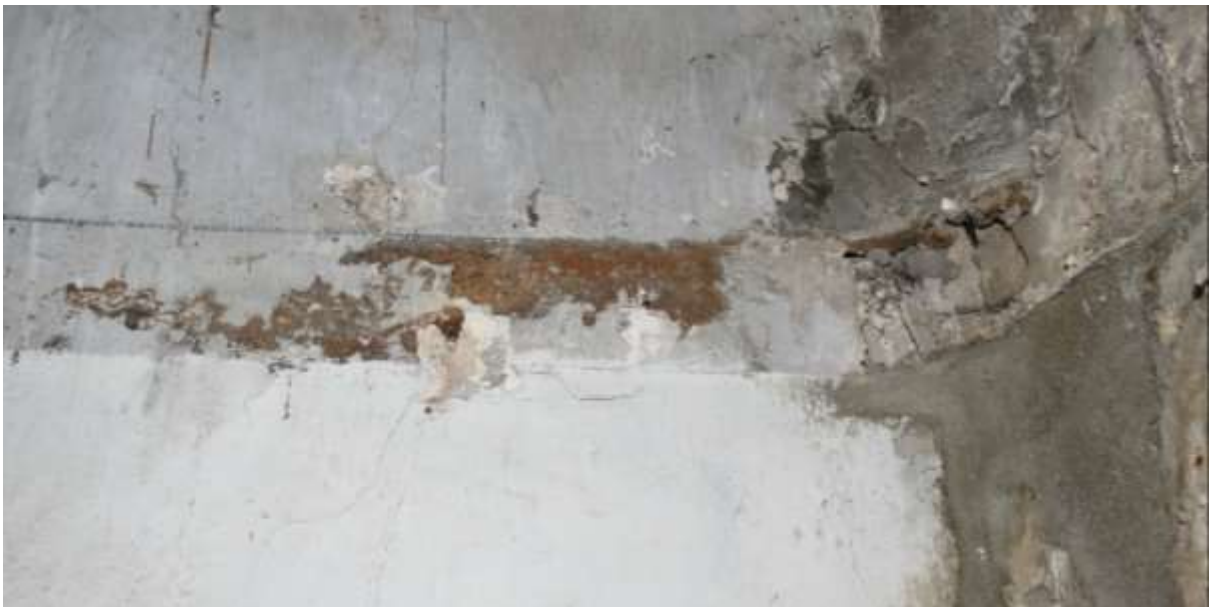
ภาพขยายในส่วนที่ลูกศรชี้ แลเห็นแผ่นไม้วางในแนวนอนของผนังอาคารแทรกอยู่ในระหว่างชั้นอิฐ
