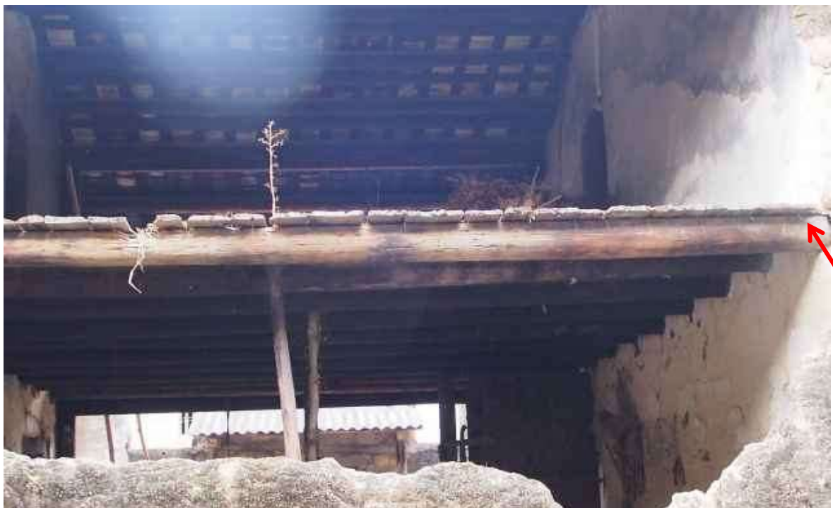
ลูกศรชี้การใช้ท่อนซุงกลมวางเป็นคานรับแผ่นไม้กระดานที่เป็นพื้นของตึกจีนในชั้นที่ ๒ และเห็นถึงการใช้นั่งรับน้ำหนักอาคาร และห้องที่ไม่มีเพดานเช่นกัน ในภาพเป็นตึกจีนในแถบมณฑลกว่างตุง
