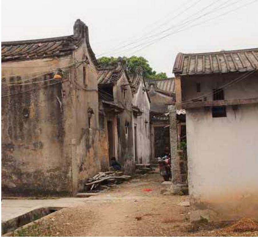
อาคารบ้านตึกจีนเก่าในแถบมณฑลกวางตุ้ง ประเทศจีน เป็นอาคารทรงตึกก่อผนังหนาใช้ผนังรับน้ำหนักอาคาร แทนระบบเสาและคาน (ภาพ: www.hakkapeople.com.)
