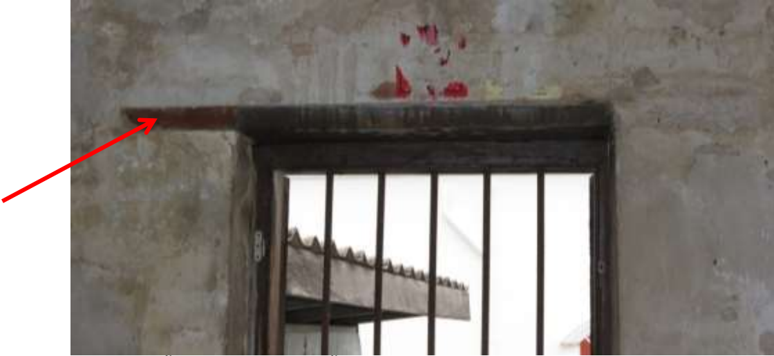
ลูกศรชี้คานไม้ที่วางพาดใช้รับน้ำหนักแนวอิฐในด้านบนของหน้าต่างในบ้านเลขที่ ๔๒๕๕
