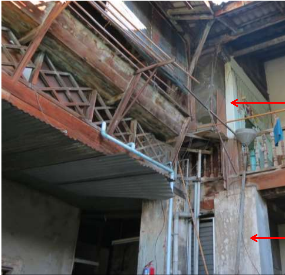
ลูกศรล่างชี้แนวเสาก่ออิฐถือปูนในชั้นล่าง ลูกศรบนชี้แนวเสาไม้ในแนวเดียวกันในชั้น ๒ สันนิษฐานเบื้องต้นว่า เสาก่ออิฐถือปูนในชั้นล่างน่าจะก่อหุ้มเสาไม้
