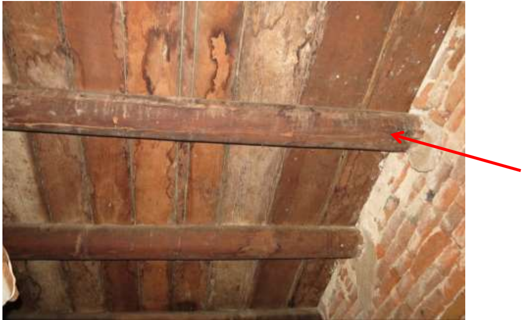
ลูกศรชี้ให้เห็นการใช้ท่อนไม้ซุงกลมวางเป็นคานแล้วจึงปูแผ่นไม้กระดานเป็นพื้นห้องของชั้นที่ ๒ ถ่ายจากเพดานของห้องชั้นล่าง ใต้บ้านเลขที่ ๔๒๔๗
