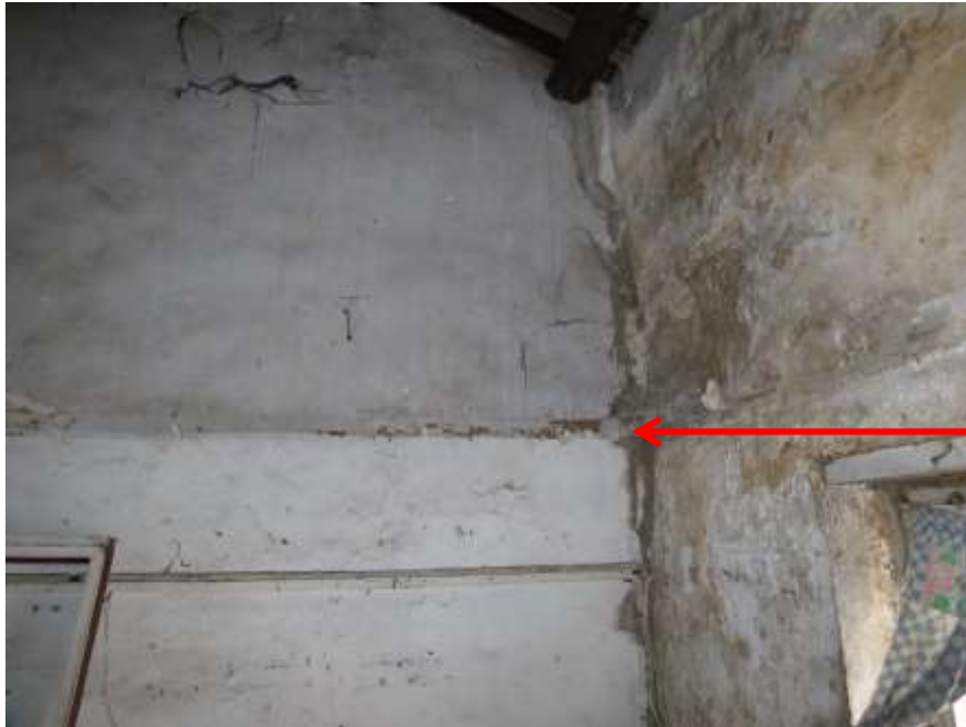
ในชั้น ๒ ผนังที่หนาของอาคารที่มีการก่ออิฐพบหลักฐานมีการคั่นด้วยแผ่นไม้ขนานกับพื้นตลอดแนวตามลูกศรชี้ ภาพจากบ้านเลขที่ ๔๒๔๗
