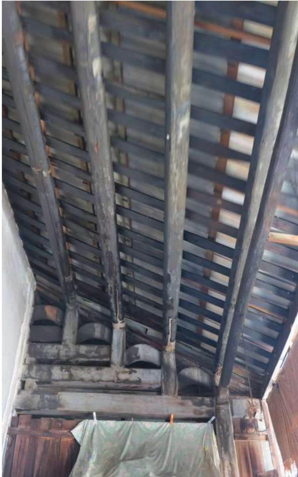
เครื่องบนหลังคาที่ทำด้วยไม้ของระเบียงในด้านหน้าอาคารฝั่งทิศใต้ จากบ้านเลขที่ ๔๒๔๗
